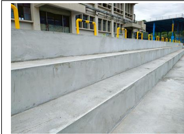
操場邊坡(0403 災損重建)
