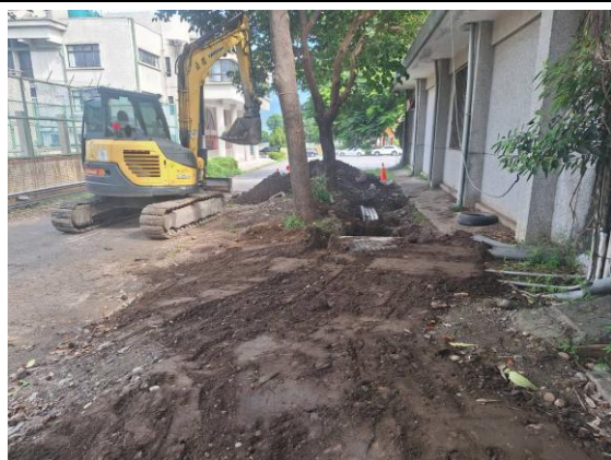
第五期電力改善(管線整併)
