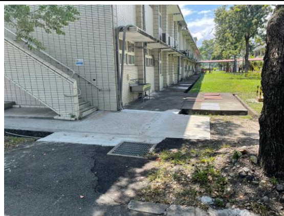
校園廊道高低差整平(第二排教室)
